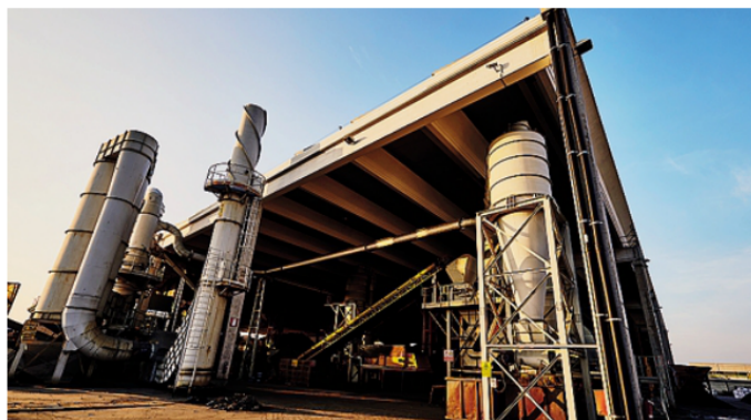
Il sito del gruppo Fecs a Comun Nuovo che verrà potenziato con ulteriori investimenti entro il 2021
